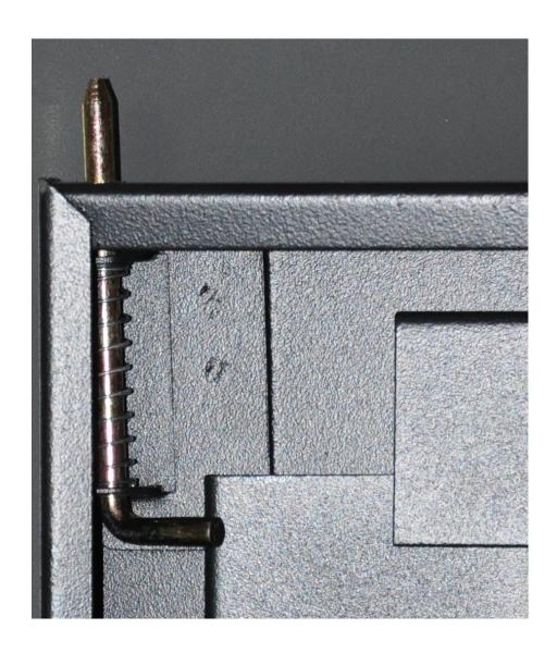
Установить переднюю (перфарированную) дверь, используя пружинный фиксатор в качестве петли
