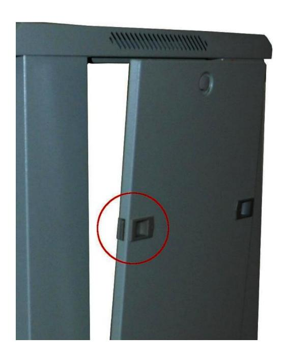
Установить заднюю (металлическую) дверь, используя пружинный фиксатор в качестве петли
